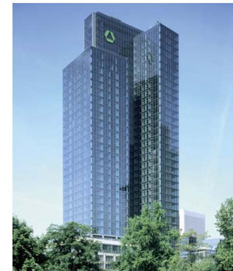
INNOVATIONSZENTRUM: Im Frankfurter Dresdner-Bank-Tower arbeiten Experten an einem umfassenden Datenqualitätsprogramm.
